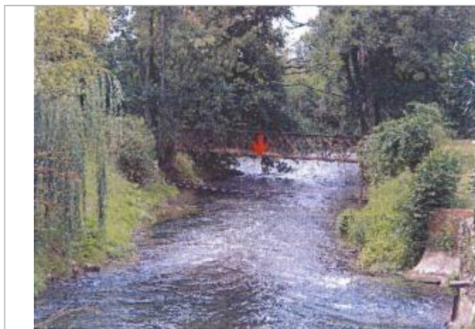
Rue du Moulin (photo CETE Normandie Centre)
