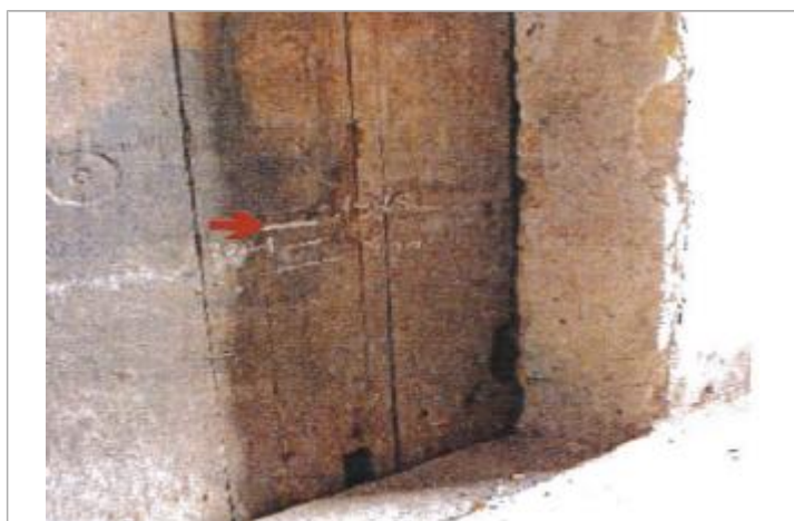
30 Rue Marie Curie (photo CETE Normandie Centre)
