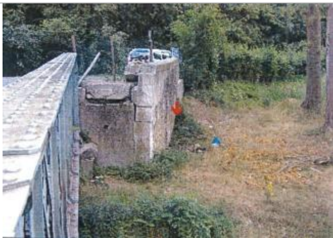
Pont des Cordeliers (photo CETE Normandie Centre)
