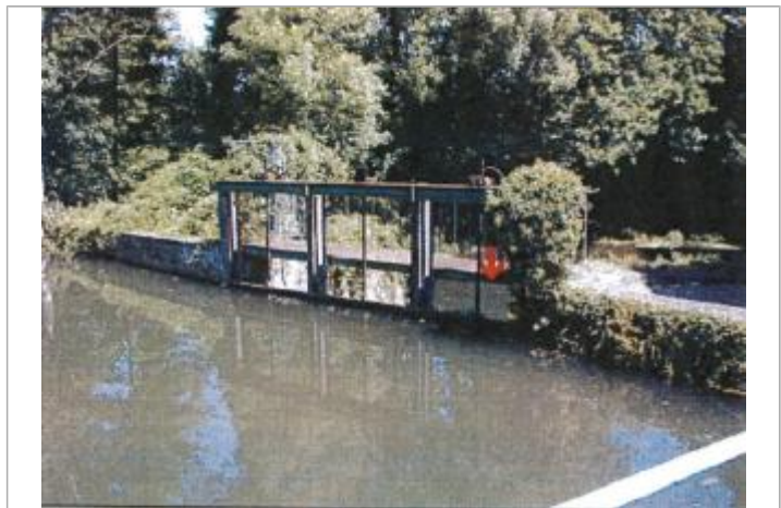
Aval usine Grands Moulins et les Cordeli (photo CETE Normandie Centre)
