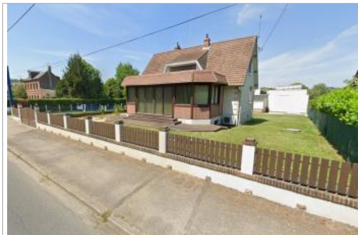
Vue depuis la rue Verdier Moretti.
