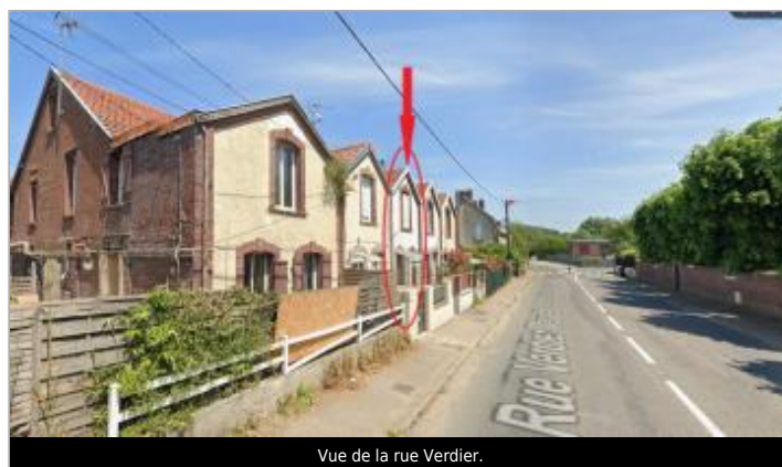
Vue de la rue Verdier.
