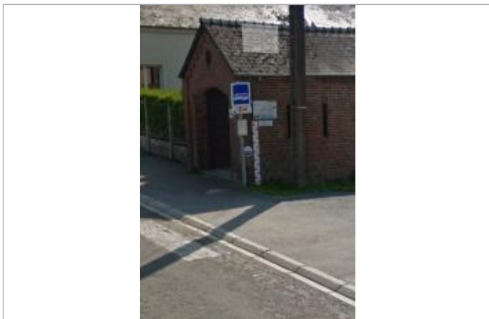
Repère de crue Assise communale
