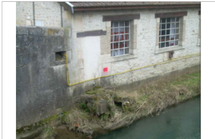
repere de crue au centre de la photo
