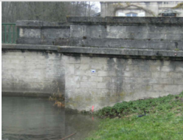
repere de crue au centre de la photo
