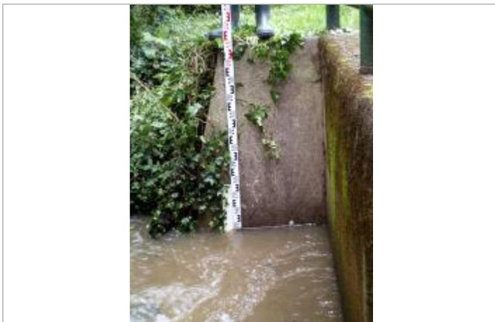
Marque d'humidité sur le mur rive gauche amont.
