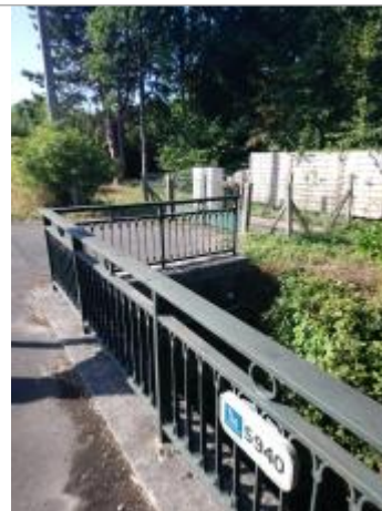
Ouvrage d'art sur la RD916
