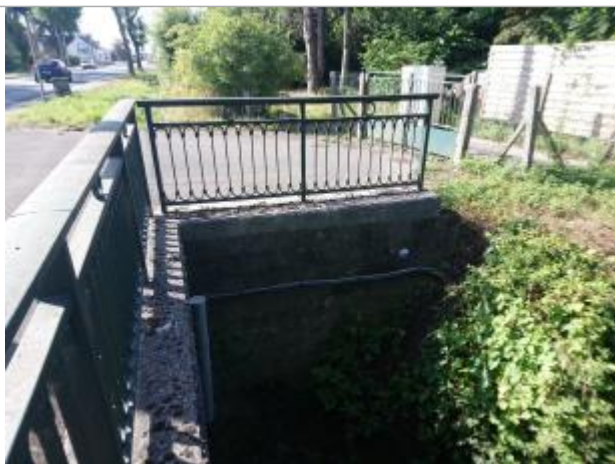
Repère de crue en rive droite de la Grande Steenbecque
