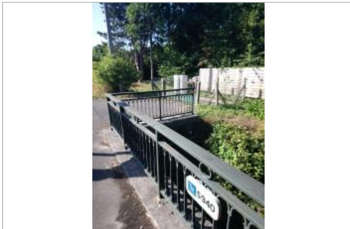
Ouvrage d'art sur la RD916
