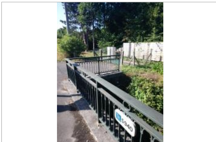
Ouvrage d'art sur la RD916
