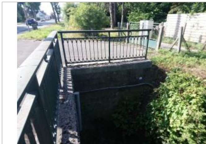
Repère de crue en rive droite de la Grande Steenbecque
