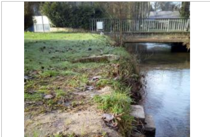
Pont de la Boissière à Breuillet (91)
