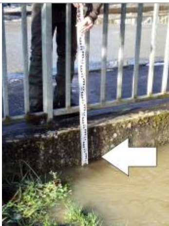
Marque d'humidité sur la face aval du pont.
