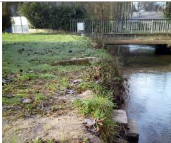
Pont de la Boissière à Breuillet (91)
