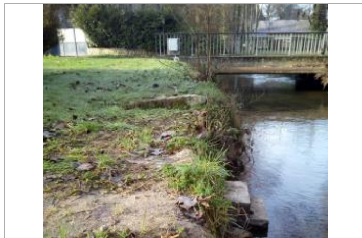
Pont de la Boissière à Breuillet (91)
