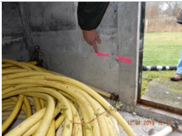
Vue à l'intérieur du local (source : SPC SACN)
