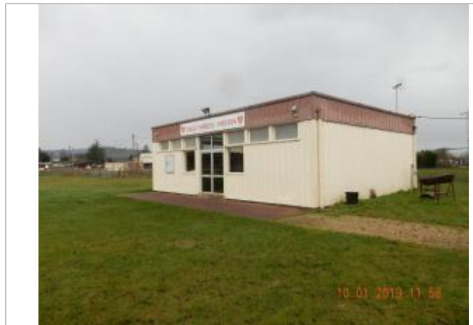
Vue sur la salle (source : SPC SACN)
