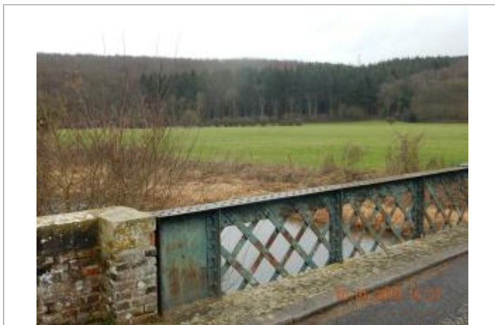
Vue de la rive droite aval depuis le pont (source : SPC SACN)
