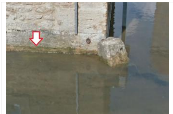
Vue du repère - Source : Google Street View (juin 2016)
