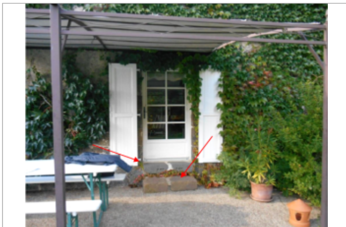
Vue du site - Source : ARTELIA
