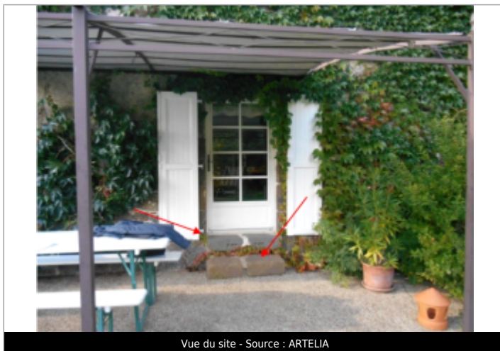
Vue du site - Source : ARTELIA
