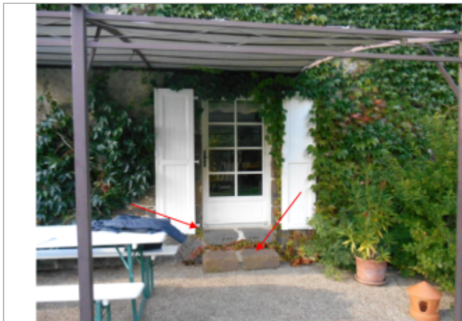
Vue du site - Source : ARTELIA
