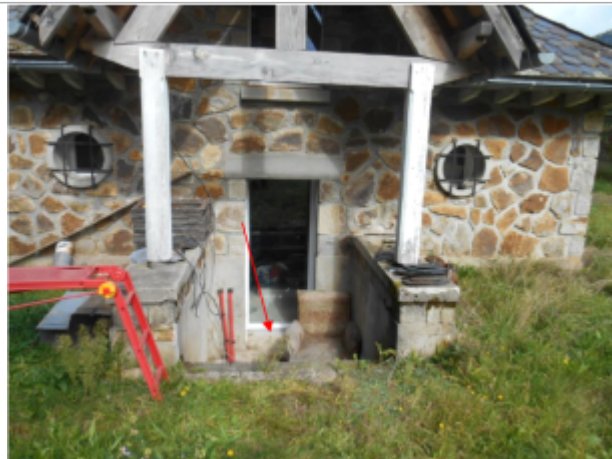
Vue du site
