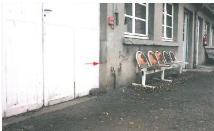
Locaux ferroviaires - Cours Montalivet (photo SPC SACN)
