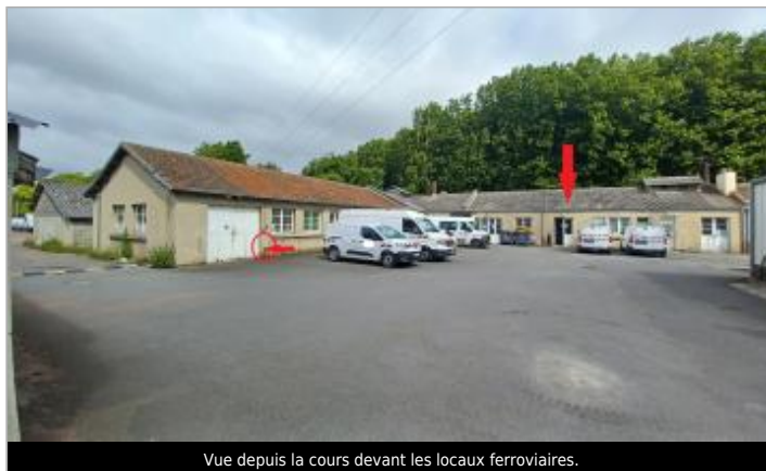
Vue depuis la cours devant les locaux ferroviaires.
