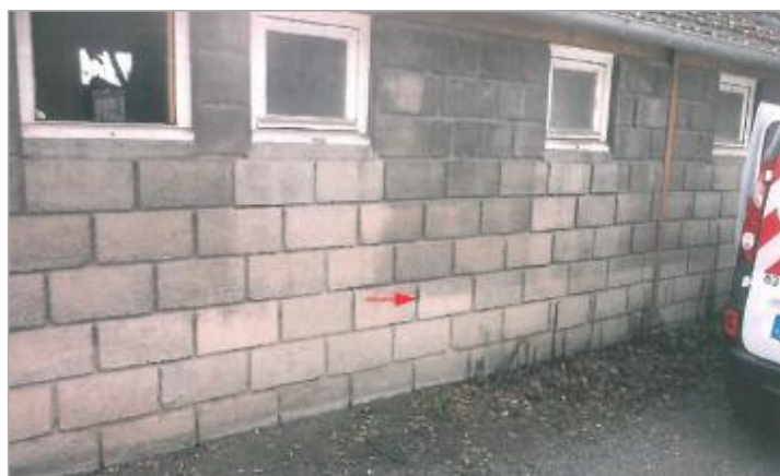
Locaux ferroviaires - Cours Montalivet (photo SPC SACN)
