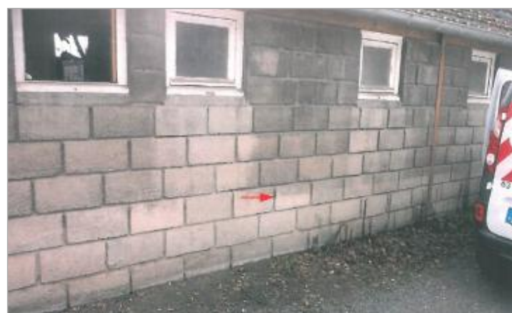
Locaux ferroviaires - Cours Montalivet (photo SPC SACN)
