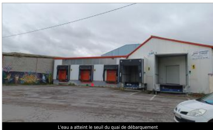
L'eau a atteint le seuil du quai de débarquement
