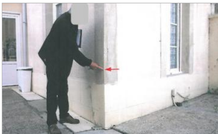
5, Rue de l'Orne (photo SPC SACN)
