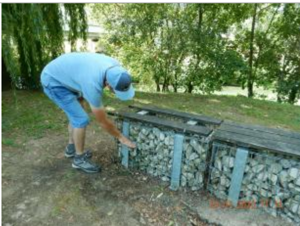
Laisse de crue sur gabion
