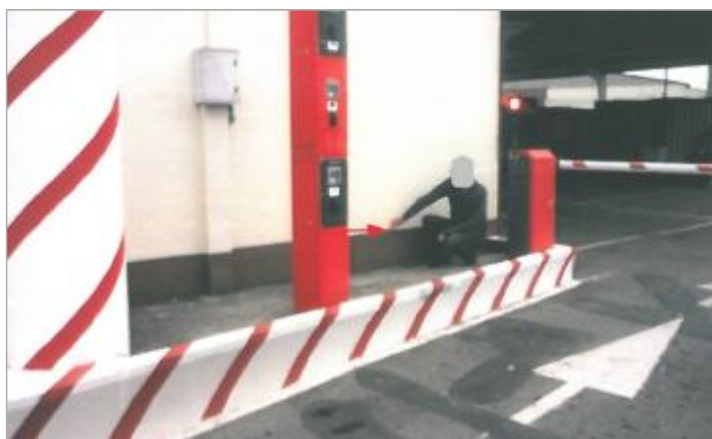
laisse de crue à 35 cm/sol (photo SPC SACN)
