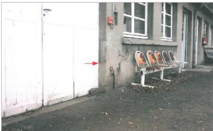
Locaux ferroviaires - Cours Montalivet (photo SPC SACN)
