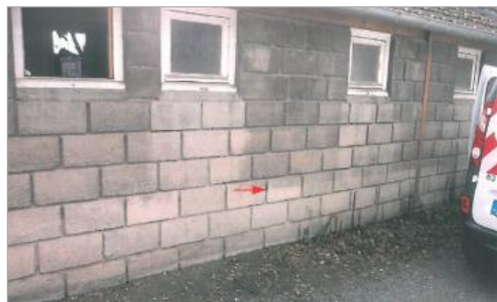
Locaux ferroviaires - Cours Montalivet (photo SPC SACN)
