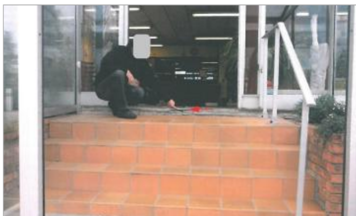
Entreprise - au bout de l'Allée du Bac (photo SPC SACN)
