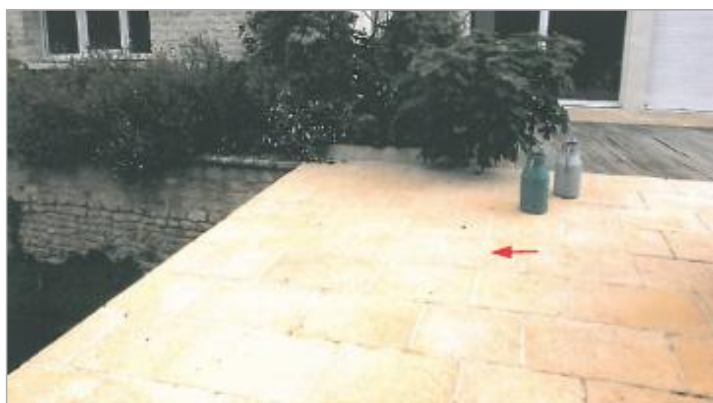
Moulin au bout de l'impasse du Dan - Passerelle amont (photo SPC SACN)
