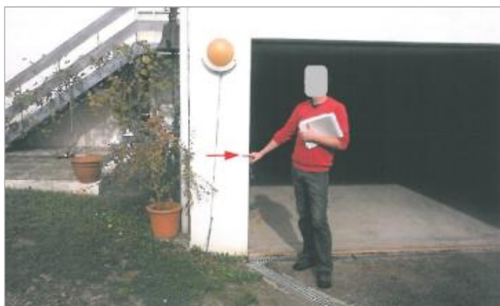
laisse de crue à 1m /sol (photo SPC SACN)
