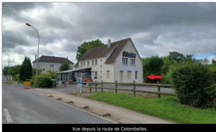
Vue depuis la route de Colombelles.
