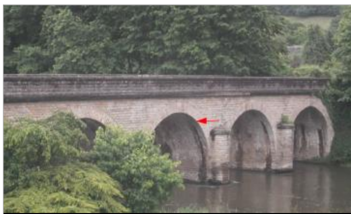
Pont de la D133A (photo Laboratoire CEREMA Normandie-Centre de Blois)
