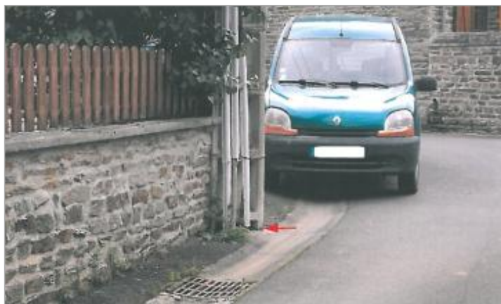
Poteau EDF - Le Pont de la Moussé (photo Laboratoire CEREMA Normandie-Centre de Blois)
