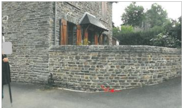
Muret - Le Pont de la Moussé (photo Laboratoire CEREMA Normandie-Centre de Blois)
