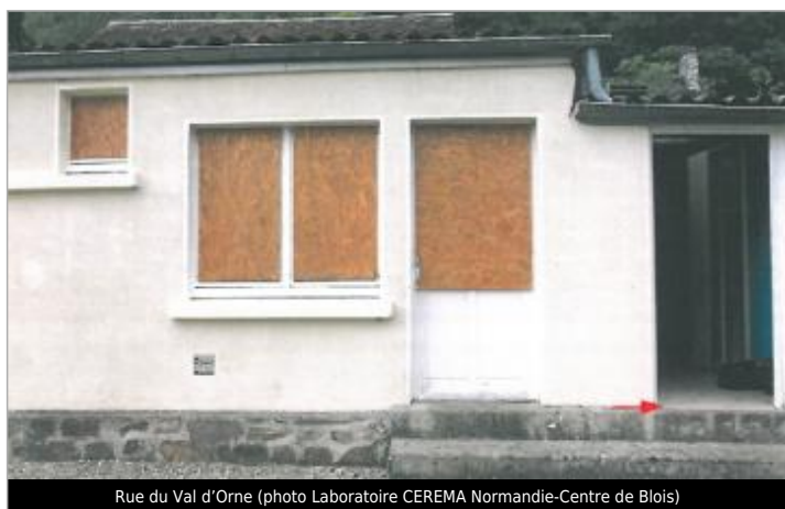
Rue du Val d'Orne (photo Laboratoire CEREMA Normandie-Centre de Blois)
