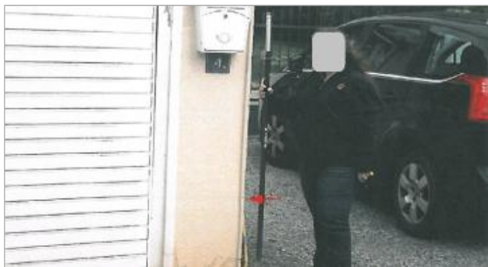
Laisse de crue à 50 cm/sol. (photo Laboratoire CEREMA Normandie-Centre de Blois)
