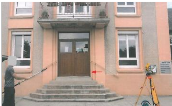
Mairie - 17, Grande Rue (photo Laboratoire CEREMA Normandie-Centre de Blois)
