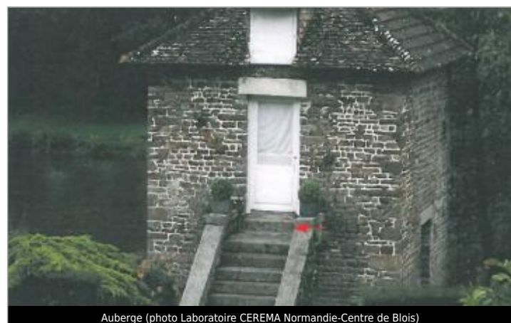
Auberge (photo Laboratoire CEREMA Normandie-Centre de Blois)
