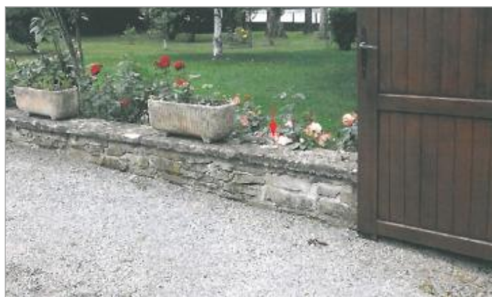
Le Pont de la Moussé - Chemin du Gué (photo Laboratoire CEREMA Normandie-Centre de Blois)
