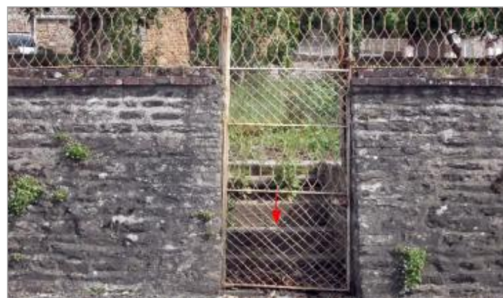
Le Bas de Caumont - D562 (photo Laboratoire CEREMA Normandie-Centre de Blois)
