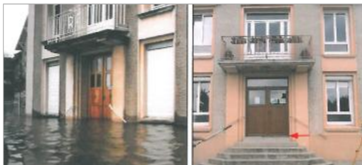
Mairie - 17, Grande Rue (photo Laboratoire CEREMA Normandie-Centre de Blois)
