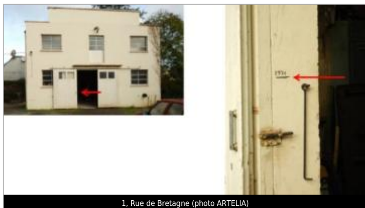
1, Rue de Bretagne (photo ARTELIA)
