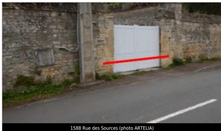
1588 Rue des Sources (photo ARTELIA)
