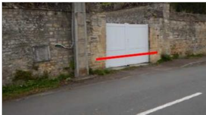
1588 Rue des Sources (photo ARTELIA)
