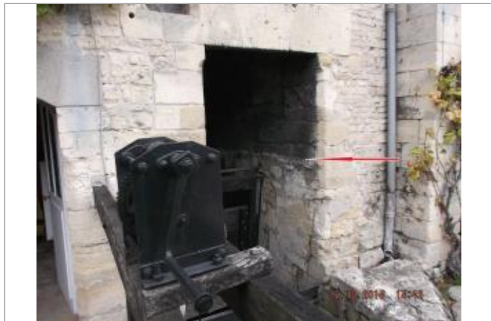
Moulin au bout de l'impasse du Dan - Passerelle aval (photo SPC SACN)
