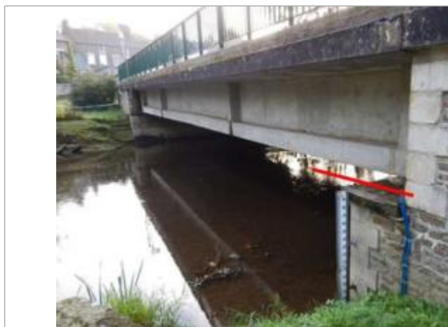
Pont D911 - Les Planches (photo ARTELIA)
