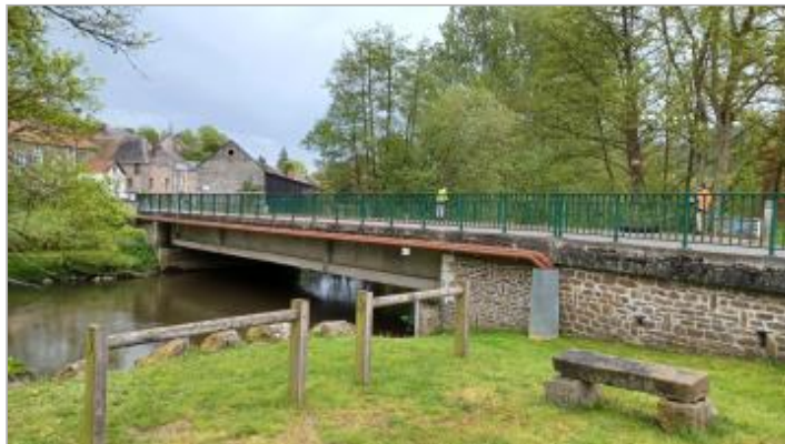
Vue du pont
