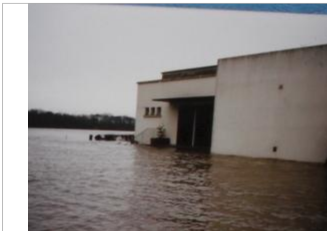
Vue depuis la rue La Haute
