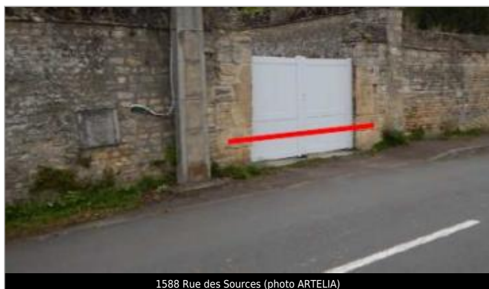
1588 Rue des Sources (photo ARTELIA)
