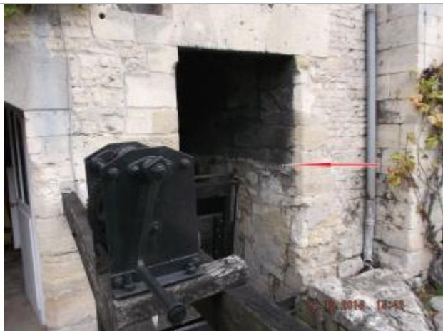
Moulin au bout de l'impasse du Dan - Passerelle aval (photo SPC SACN)
